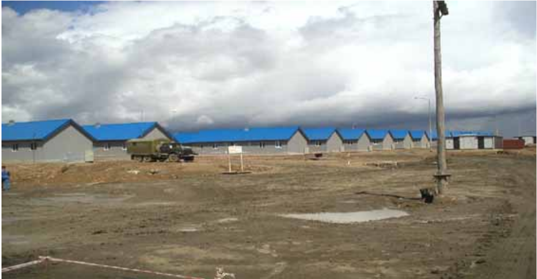
作業員用宿舎
