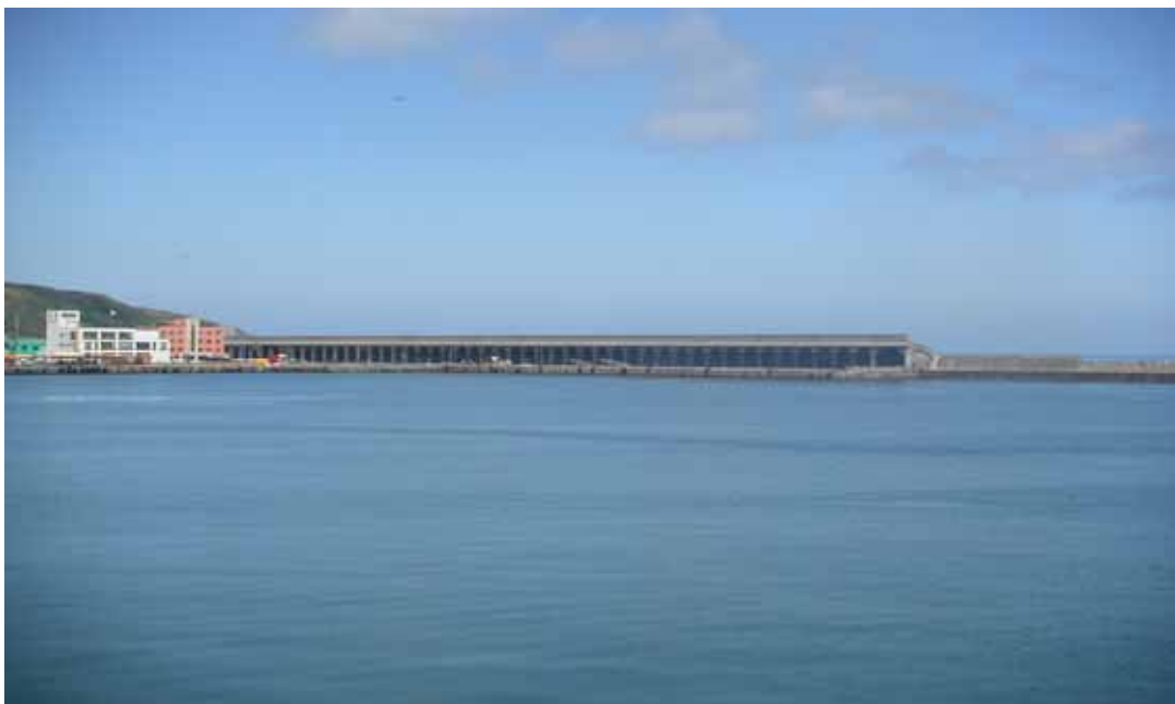
船から見る北防波堤ドーム 海は穏やかで波ひとつない
