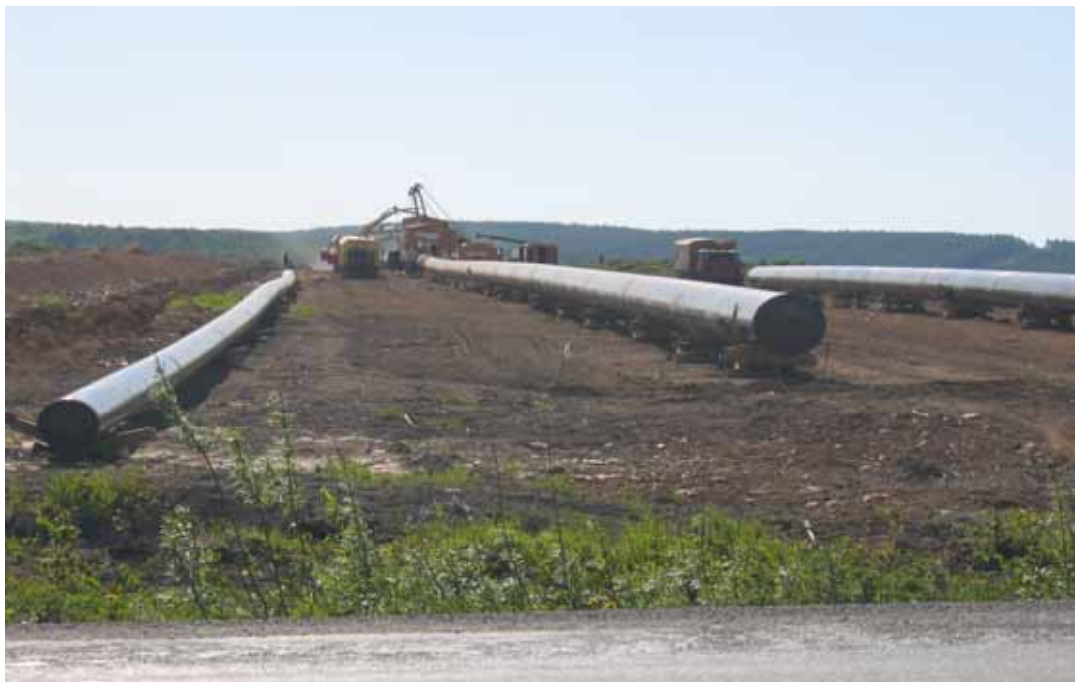
敷設作業の様子
