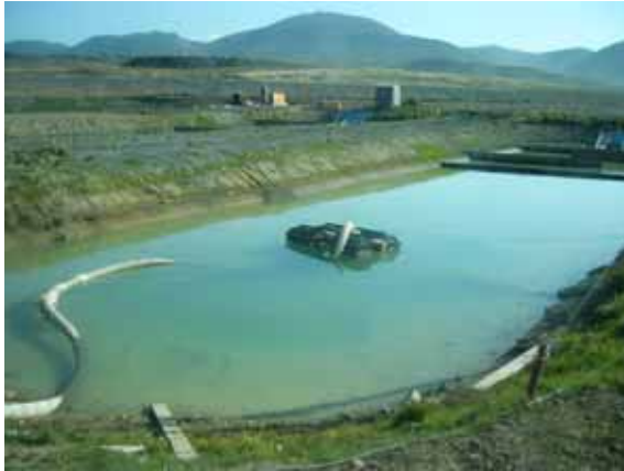
雨水処理用の沈殿地
