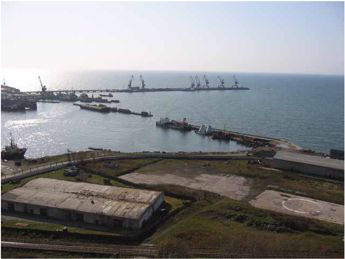
高台から望むコルサコフ港、フェリーや運搬船が接岸する岸壁には防波堤が無く自然の影響をダイレクトに受ける。
