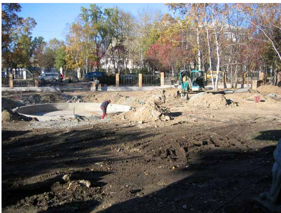
工事中の前庭
