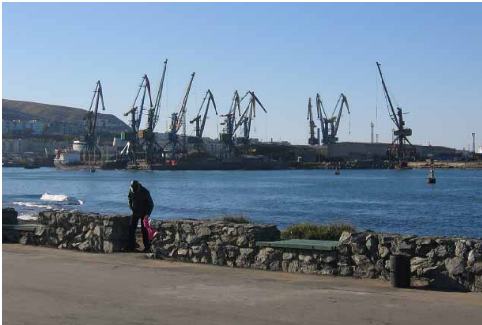
老朽化が進む港湾施設
